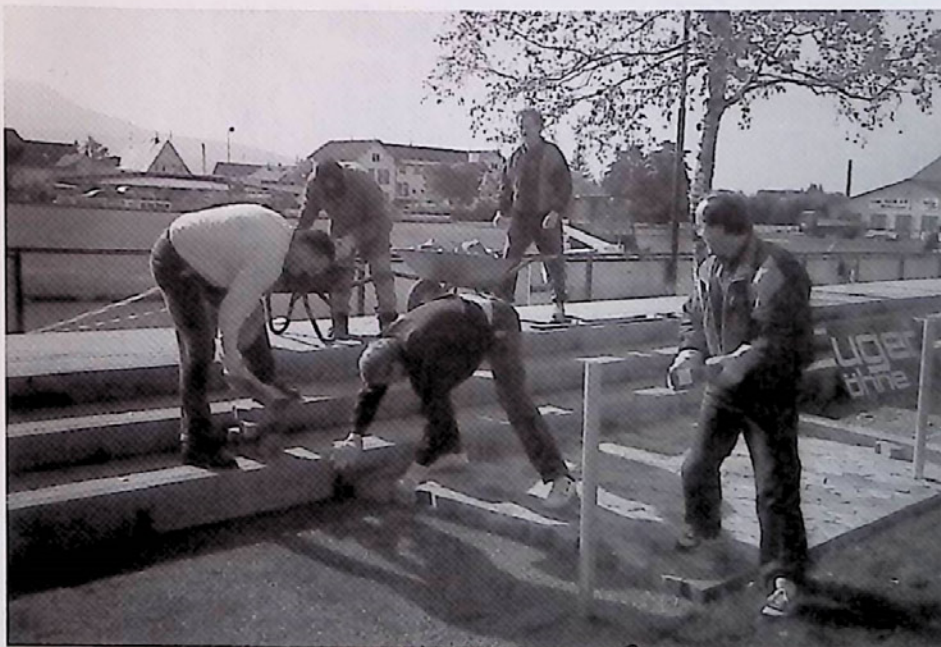
Beim Stehwallbau - Arbeitseinsatz der Fußballer
